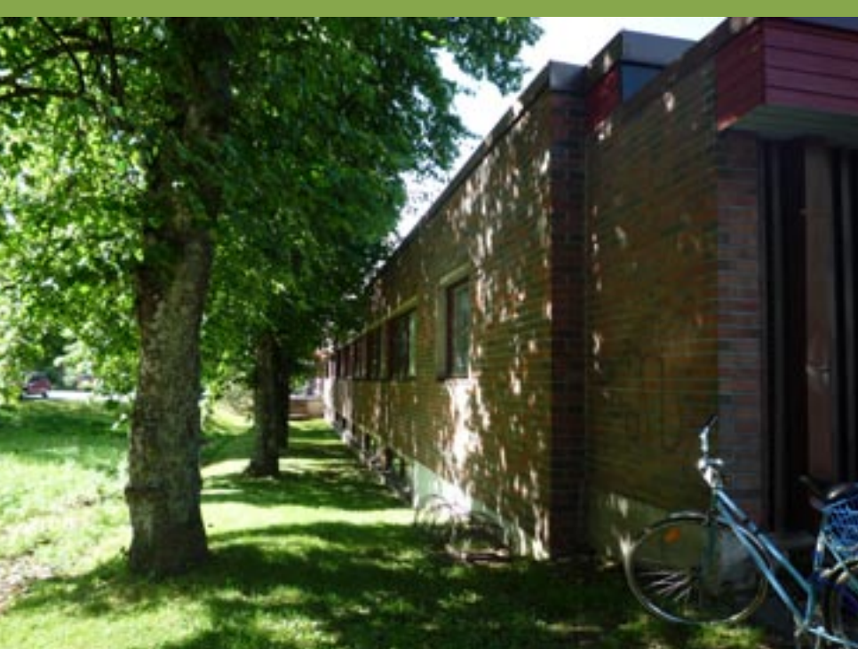
Kunnanvirasto on tyyliään puhtas 70-lukulainen.
